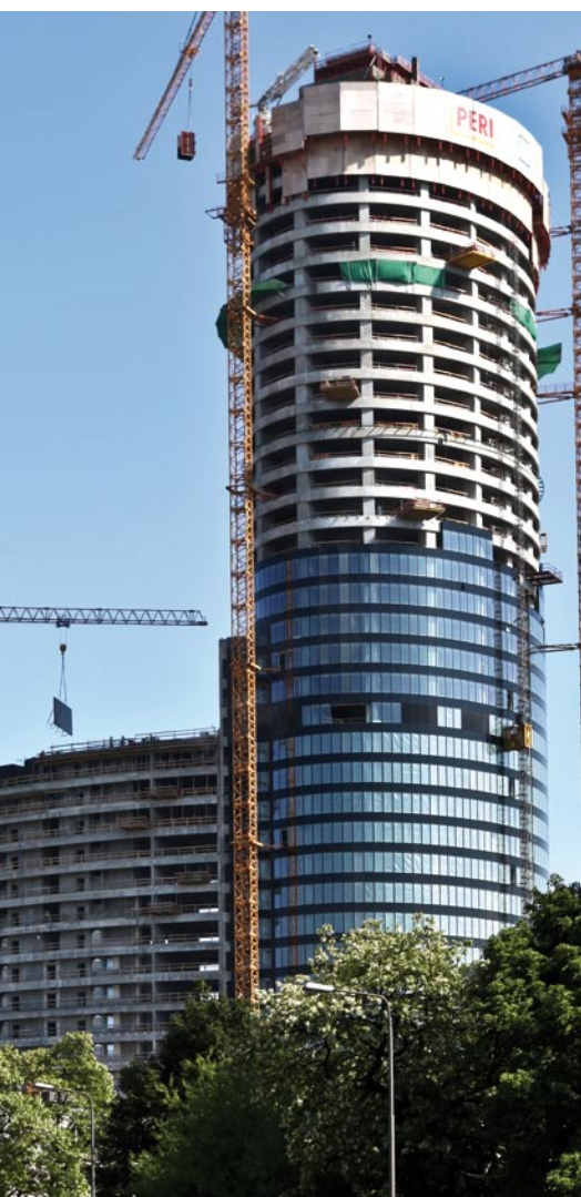
▲ LC Corp S.A. - Wrocław, Pl. Powst. Śl. 95 - Sky Tower
